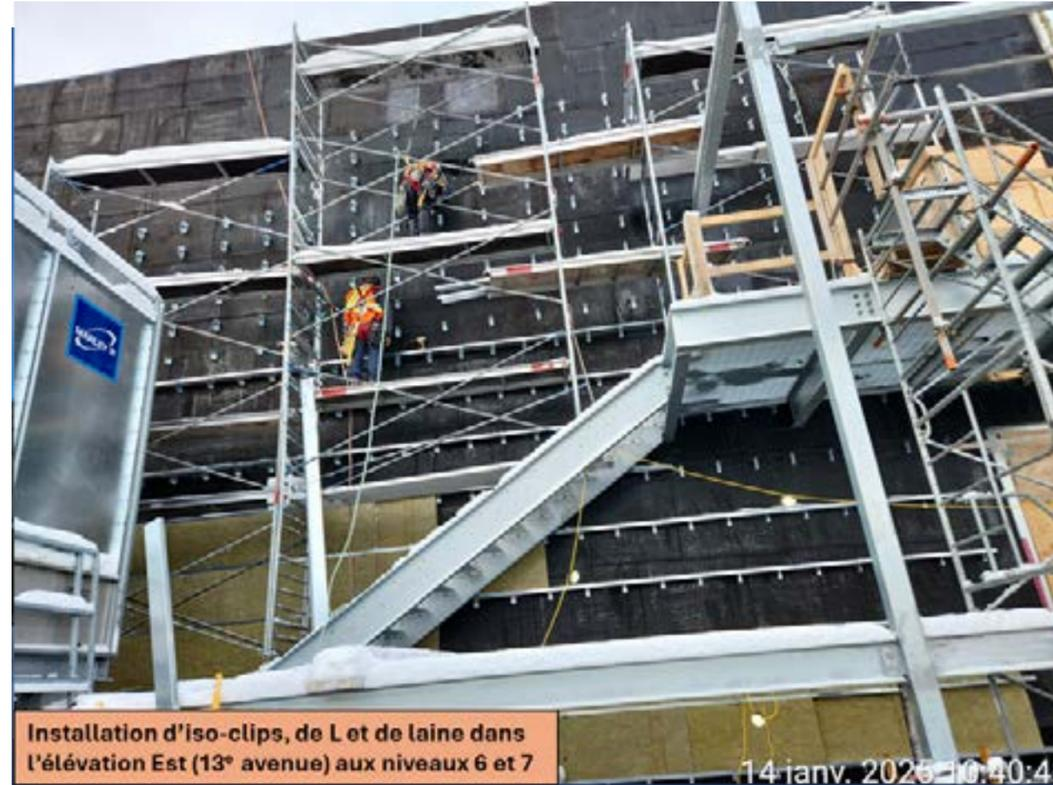
Installation d'iso-clips, de L et de laine dans l'élévation Est (13<sup>e</sup> avenue) aux niveaux 6 et 7
